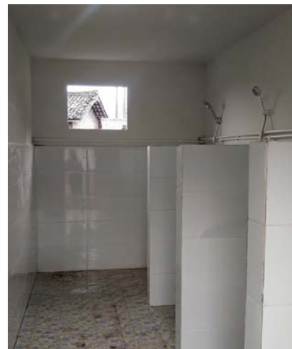
马拖社区能力发展项目 - 为村民们修建浴室
